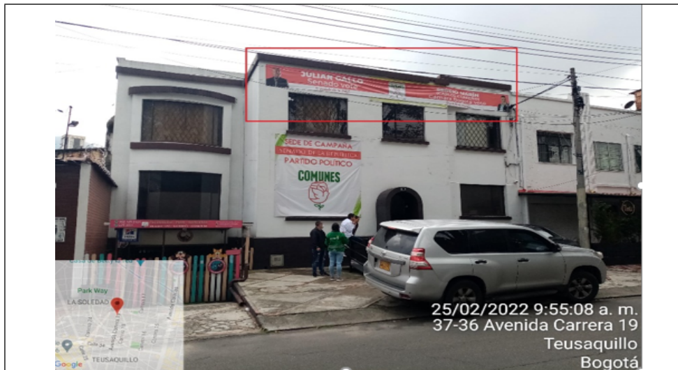
Foto No. 2 Vista panorámica del predio donde se ubica de la sede política de campaña del candidato al senado JULIÁN GALLO CUBILLOS del partido político COMUNES , así mismo se puede evidenciar un elemento tipo aviso en fachada ubicado en la parte superior del segundo piso el cual no cuenta con registro ante la Secretaría Distrital de Ambiente.
